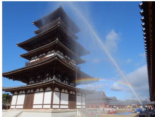
●薬師寺東塔防災施設整備事業 (令和2年12月17日撮影)
