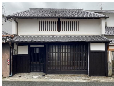
【修理後】 令和2年8月12日撮影
