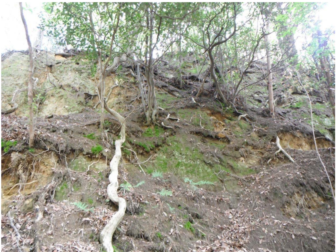
P-56 : 直壁状の礫岩露頭。風化を受けておりピックハンマーで削ることが可能である。
