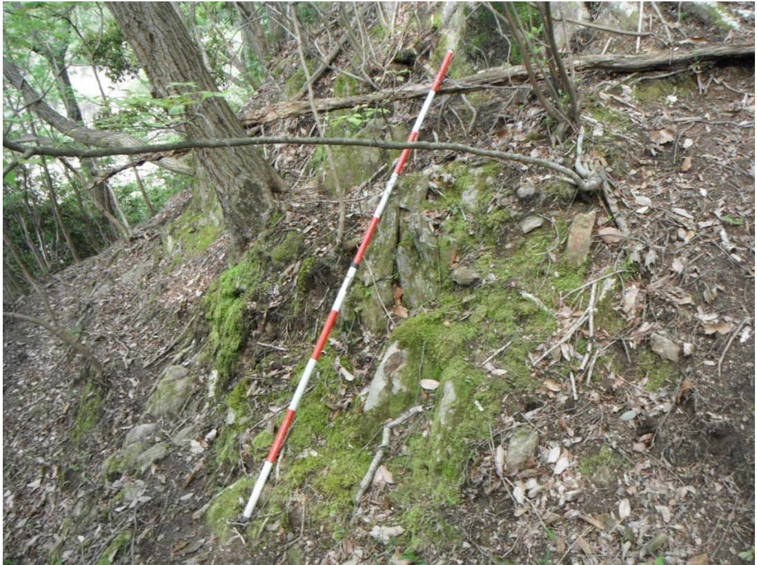
P-63 : 北向き斜面は、急傾斜を呈しており、多くの露頭（片麻岩）が確認できる。
