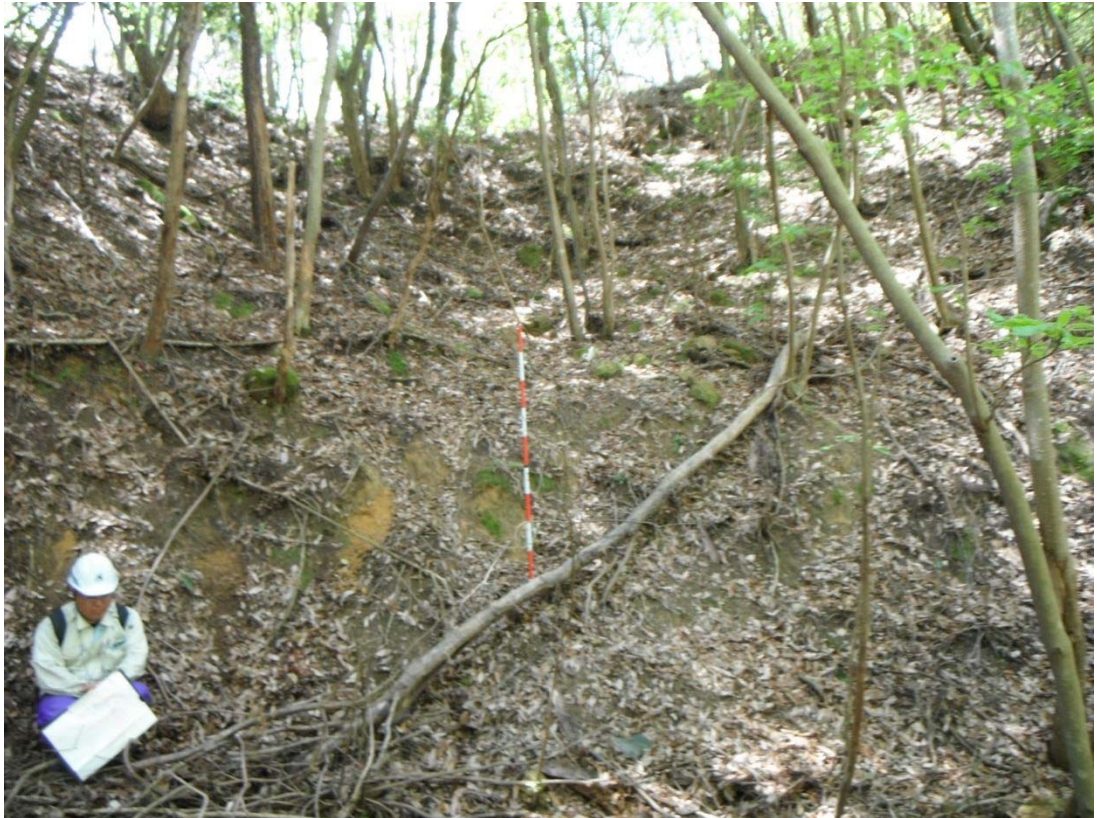
P-47 : 谷部の崩壊跡。
