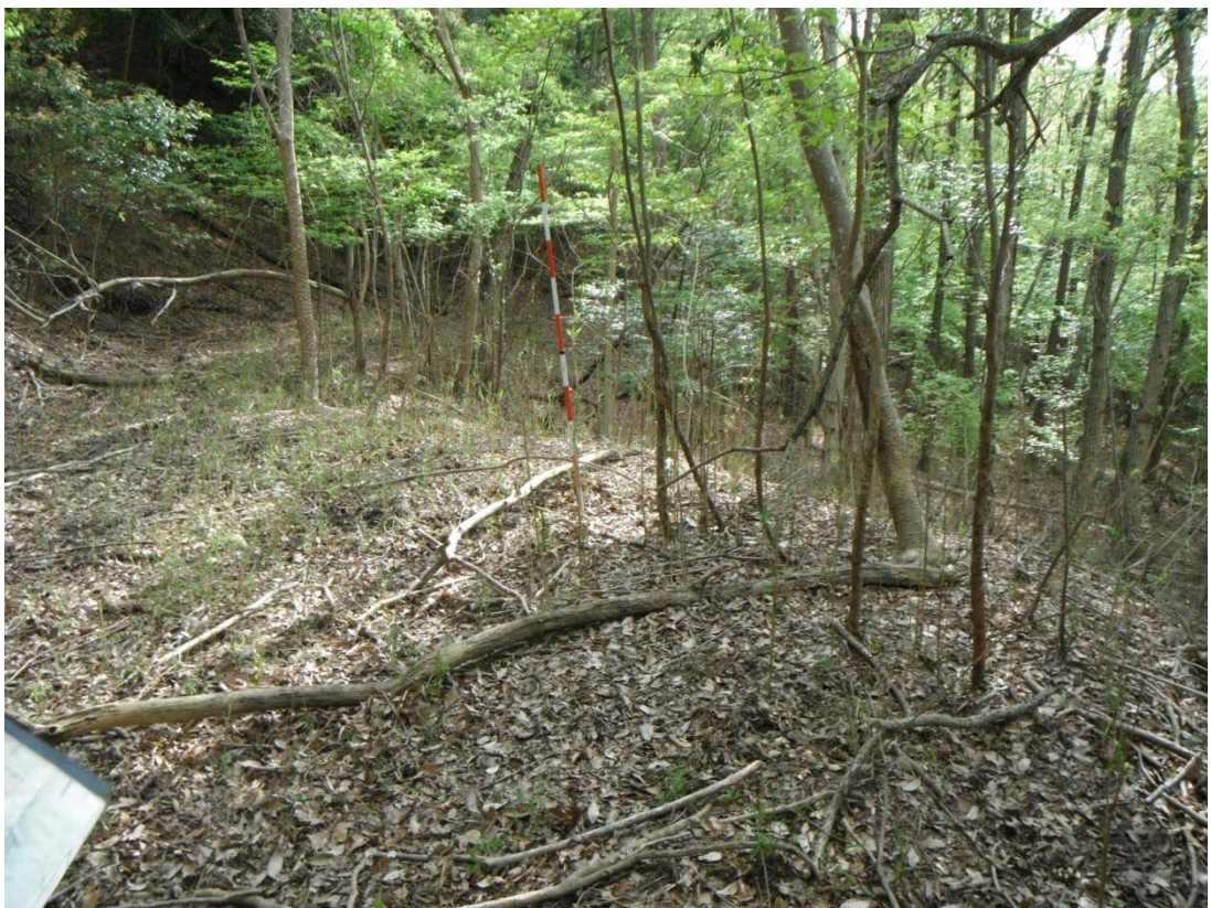
P-66 : 擁壁工～切土の境界区間付近。古い崩壊跡があり、堆積土砂が被覆している。
