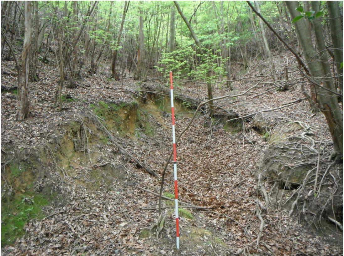
P-49：谷部の崩壊跡。滑落崖に岩盤は確認されない。
