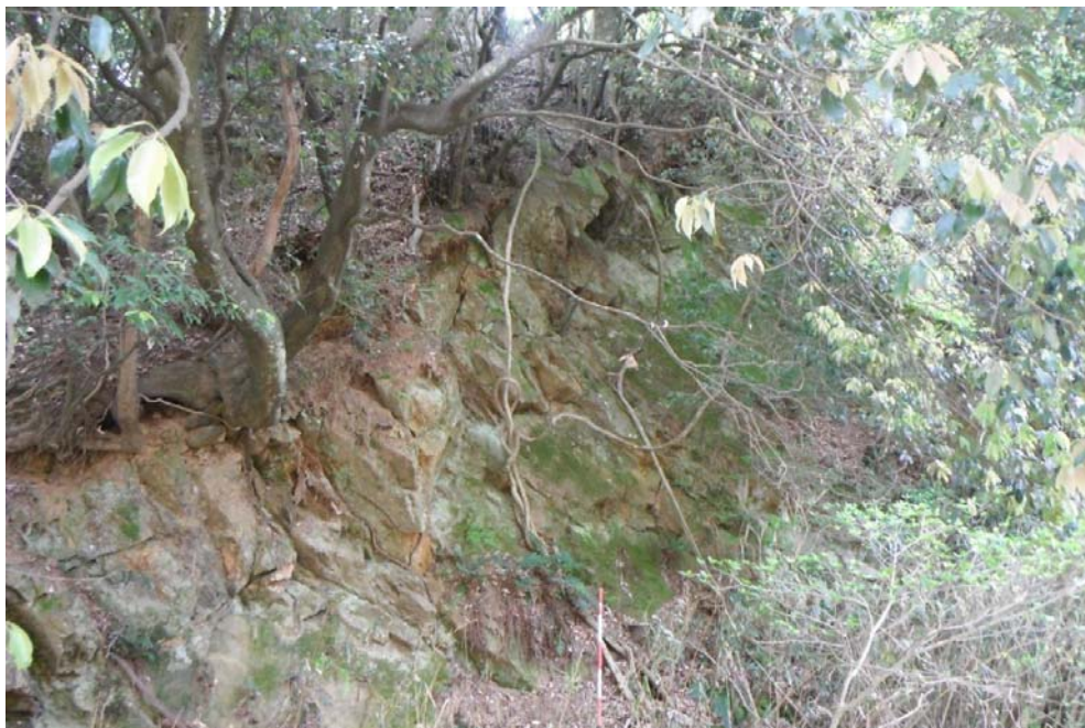
写真-6；岩井川の砂防ダム左岸側の斜面状況。硬質な片麻岩の露頭が確認される。節理面は、EW 60N、N60W 50N が卓越している。(P-80)
