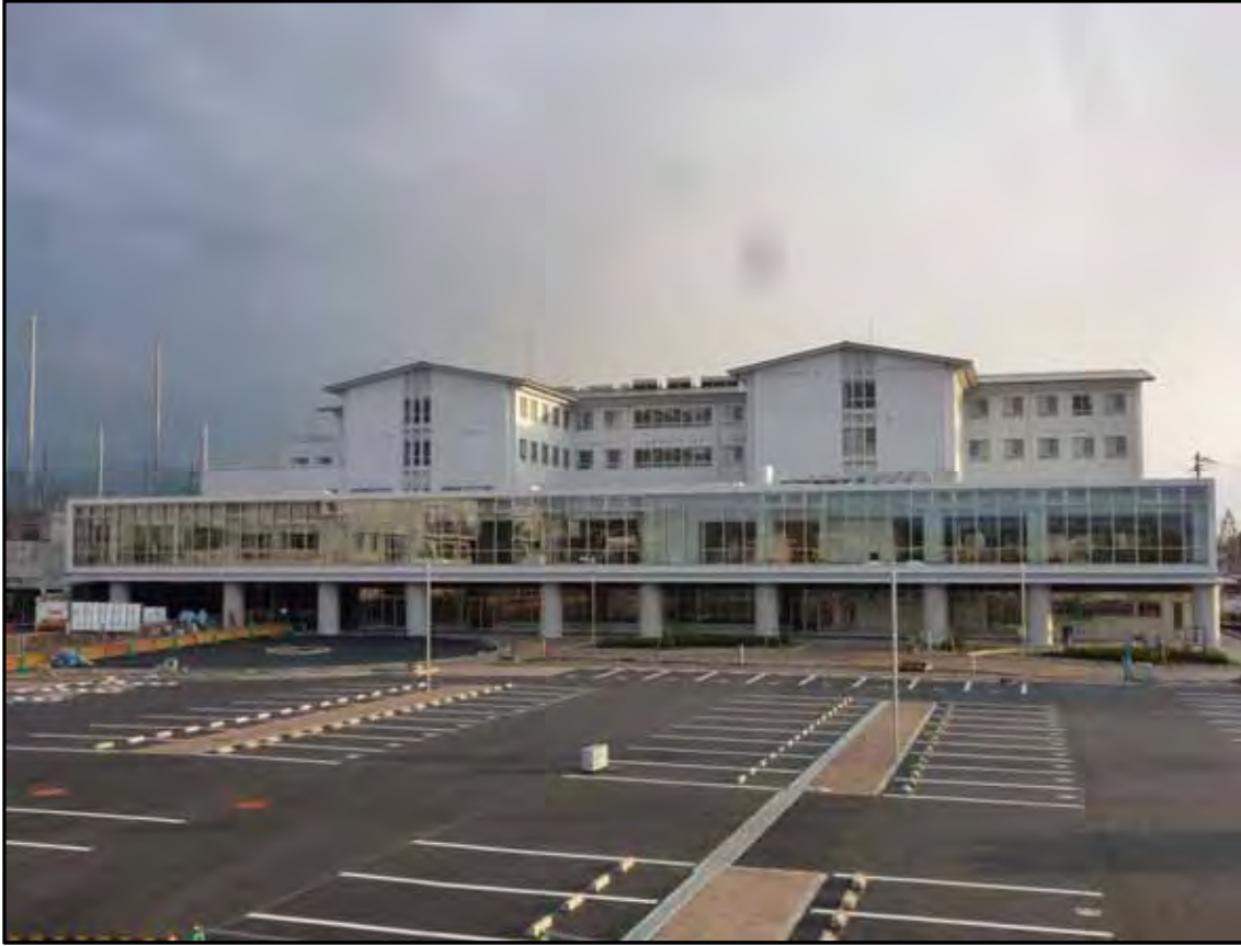
別館・駐車場
