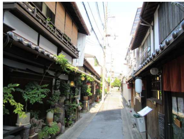
【町家を活かした店舗が建ち並ぶ通り】
