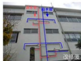
埋設されていた配管を改 修の際に露出化で更新
