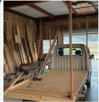
製作中のキッチンカー。完成が待ち遠しいです。
