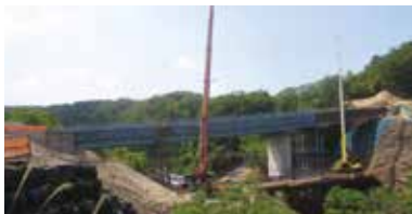
4 上部架設工事（令和2年5月）
