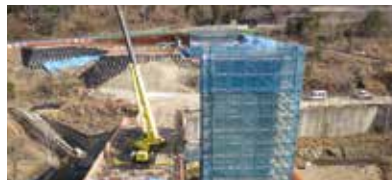
2 橋脚鉄筋組立～コンクリート打設工事（令和2年1月）
