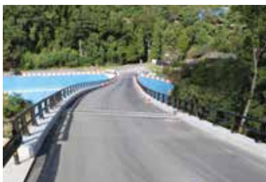
5 橋梁完成（令和2年8月）
