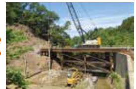
1 橋脚の仮設工事（令和元年5月）
