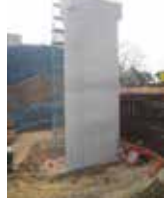
3 橋脚の躯体工完了（令和2年3月）
