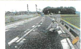
管路の点検、補修(3)
