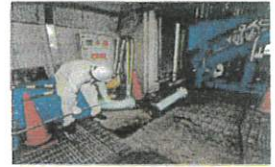
沈砂分離設備の簡易故障修理
