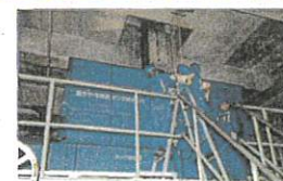
貯水ケーキ移送ポンプ用ホッパーの修
