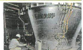
焼却設備の点検
