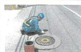
管路の点検、補修(1)
