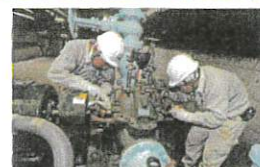
処理水ポンプの分解修繕
