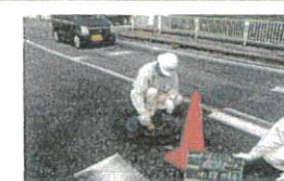
管路の点検、補修(2)
