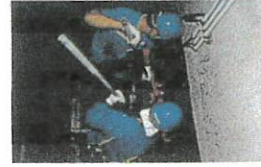
除塵設備の清掃(し清掃き上)
