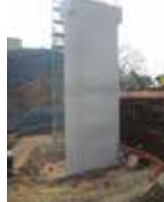
3 橋脚の躯体工完了 (令和2年3月)
