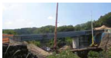
4 上部架設工事 (令和2年5月)
