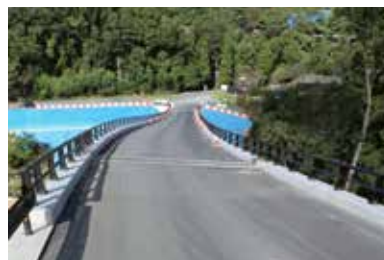
5 橋梁完成 (令和2年8月)
