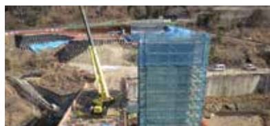
2 橋脚鉄筋組立～コンクリート打設工事 (令和2年1月)
