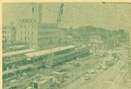
駅前工事現場
