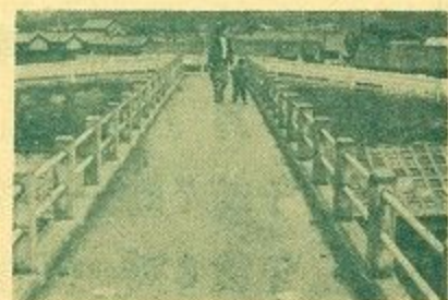
完成した栄楽橋
