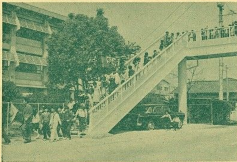
完成した市立都跡小学校前歩道橋
