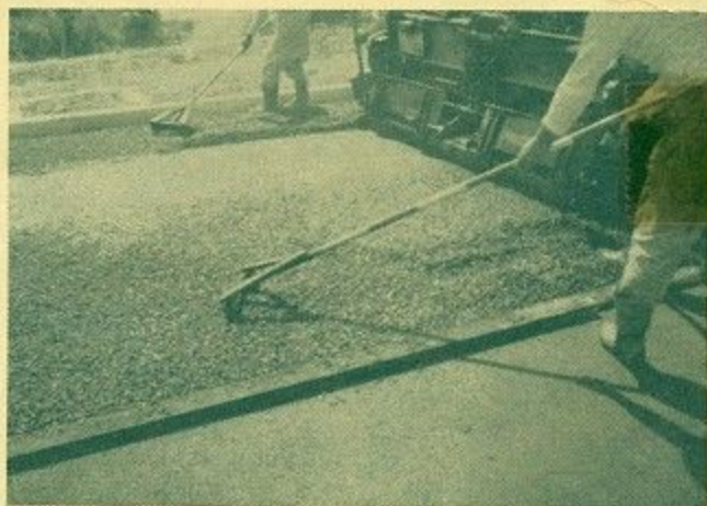
(道路舗装現場)
