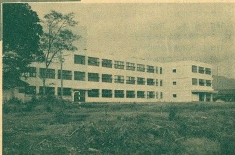
(美しい校舎に生れ変わった明治小学校)
