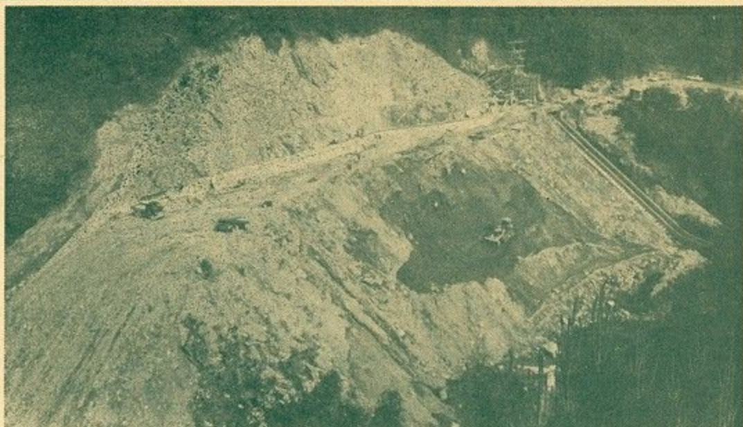
須川ダム予定地にダムに先きだってパイパス管路の完成も間近か（この夏には12,000トンの水が送られる）
