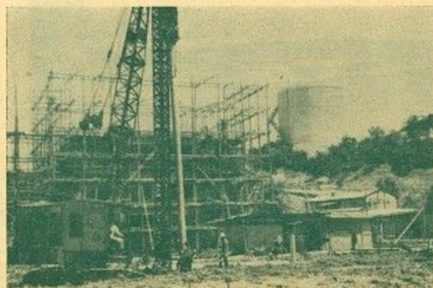
登美が丘に完成の大淵配水塔(容量2,650トン)
