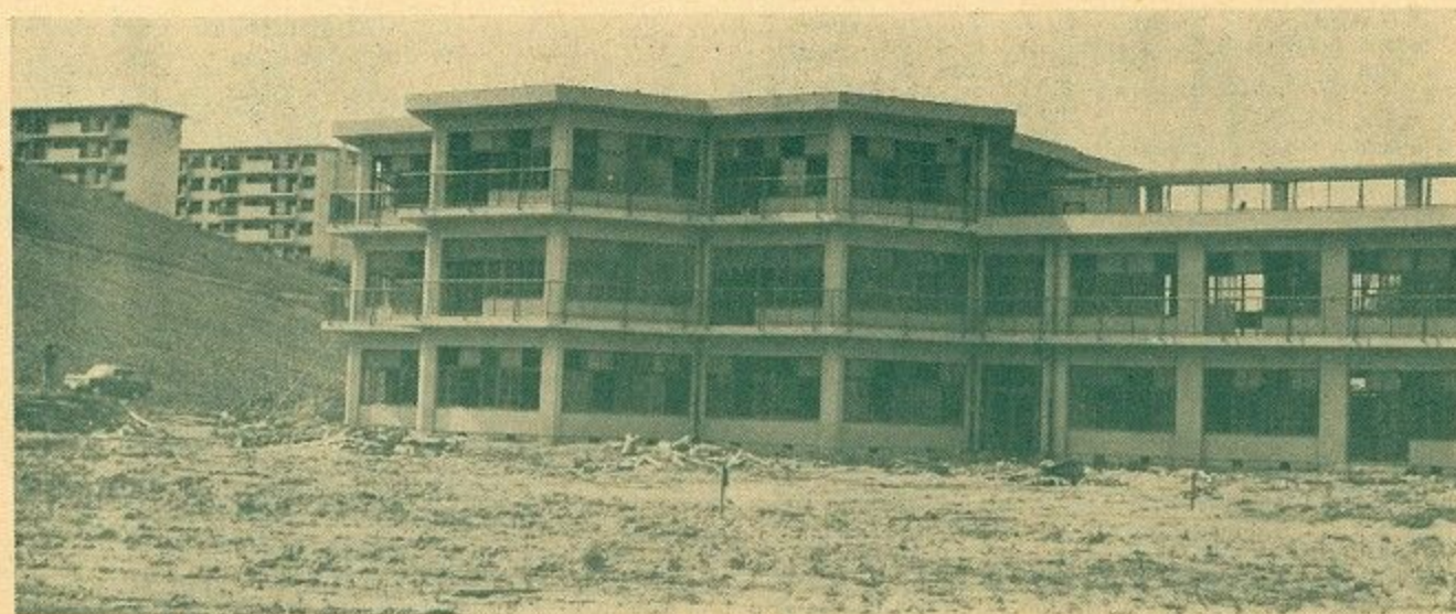
(新築なった鳥見小学校々舎)
