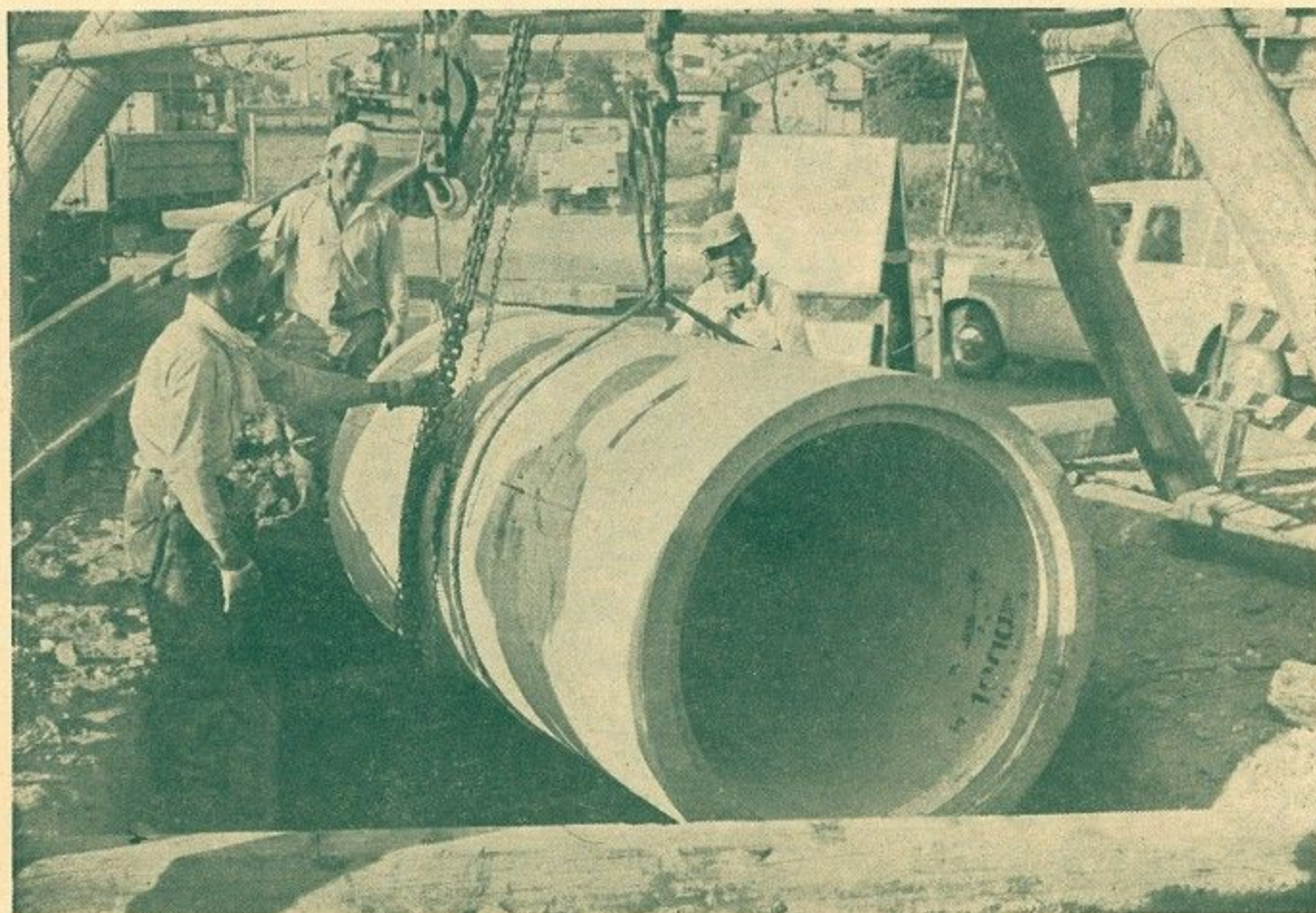
市内における下水道幹線の埋設工事現場
