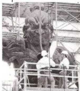
東大寺境内の修理場で足場を組んでの大がかりな修理作業
