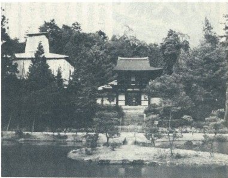
緑に包まれた円成寺（正面が山門、その左 シートで覆われたのが建設中の多宝塔）
