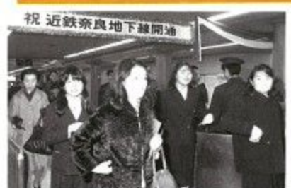
近鉄奈良駅地下へ 昭和44年12月、近鉄 の地下乗り入れ工事が完成。
