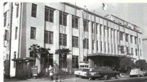
再建された新庁舎 昭和23年に焼失。新庁舎は25年に完成。
