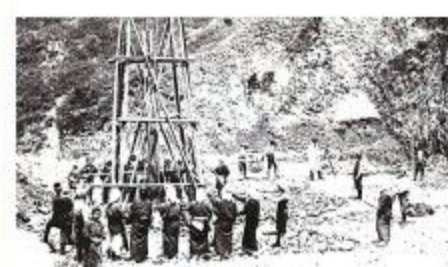
高地区配水池の床固め工事 初期上水道工事は大正11年に完成。総工費は153万円。当初の給水戸数は2,706戸。
