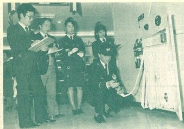
特定防火対象物の防火設備を厳重に点検
