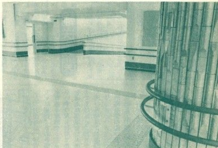
階段はスロープにし、床面には点字誘導路を敷き、壁面・柱面には手すりをめぐらしている(市身障者福祉センター「みどりの家」で)
