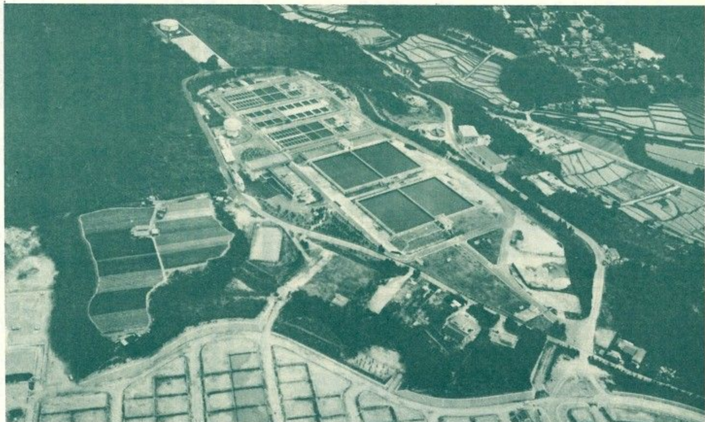
一日十万吨以上の浄水能力で「命の水」を贈る緑ヶ丘浄水場
