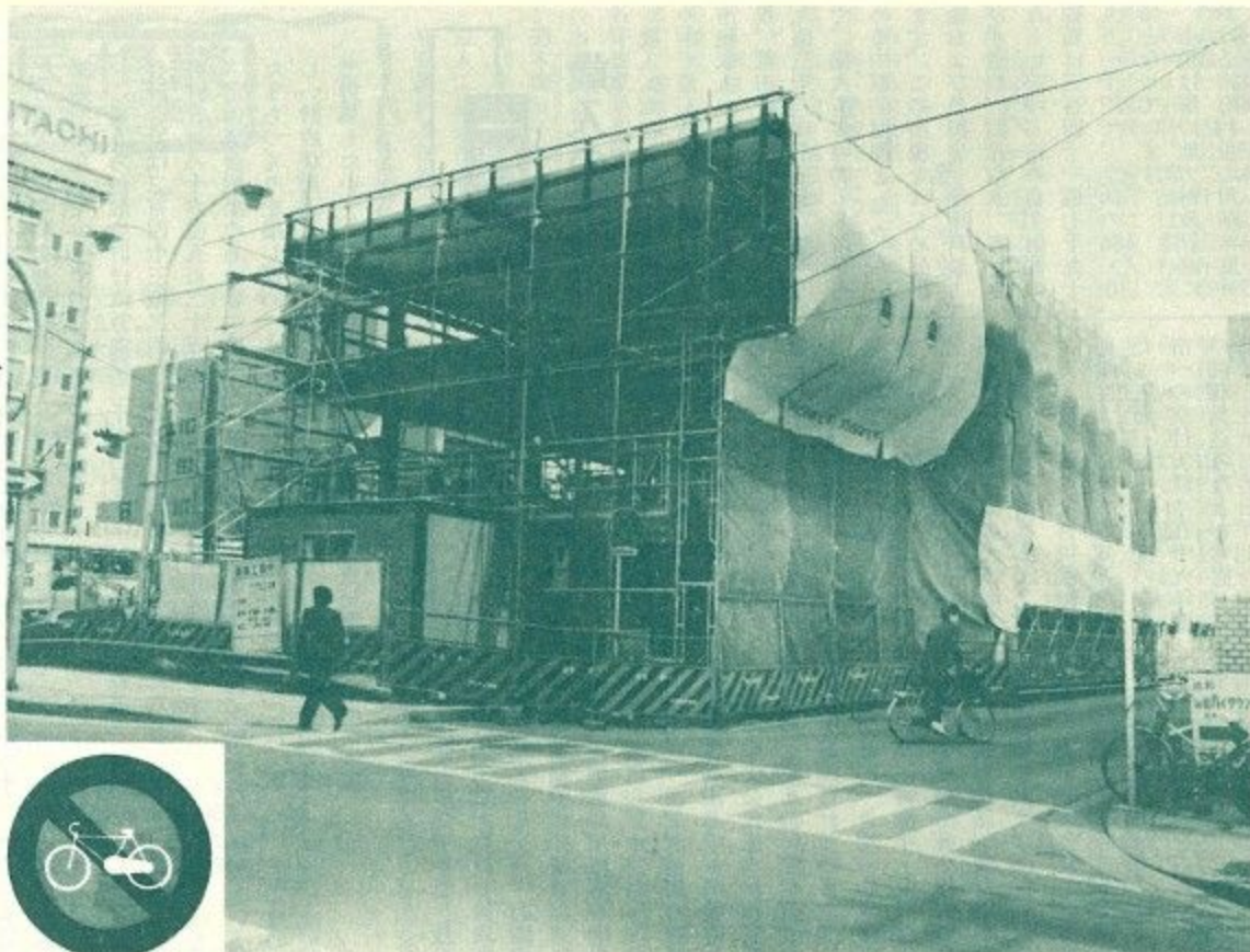
屋上に継ぎ足して大増設工事を進める近鉄奈良駅の自転車駐車場
