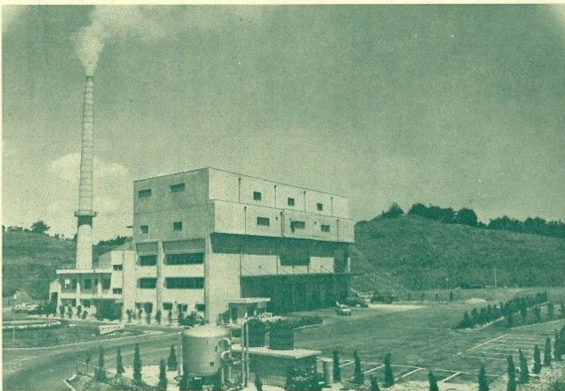
破碎機が増設される清掃工場
