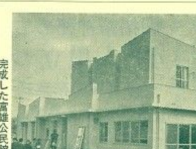
完成した富雄公民館
