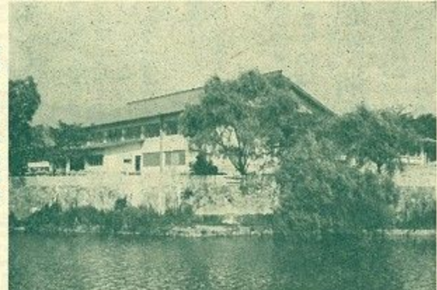
完成した中央武道場
