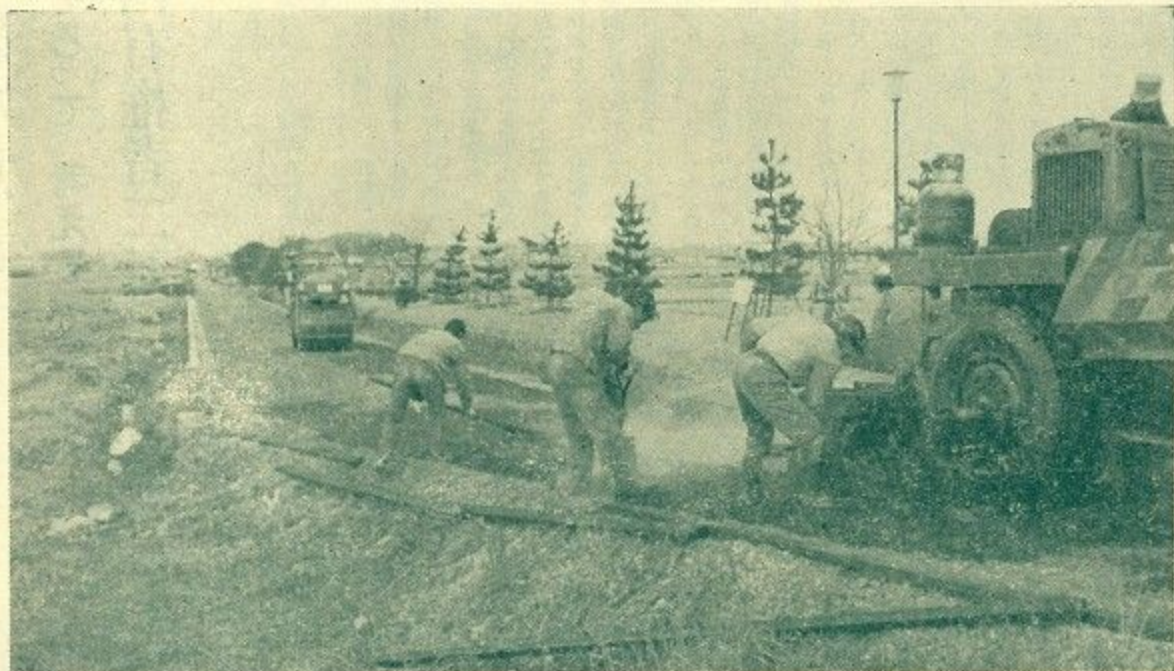
急ピッチで進む舗装工事
