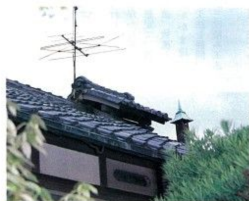
△煙拔き 横にあるのは煙突で、これは銅板で屋根をつくったイキなもの。
