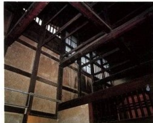
△明りとり 通り庭の吹きぬきには明りとりがあり、採光と通風をはかった。
