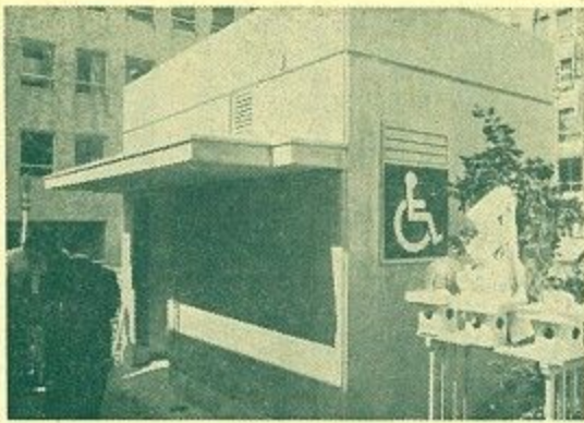
完成した身障者用便所
