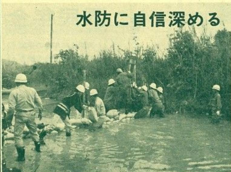
また六日には中消防署が東九条町の岩井川で水防訓練を実施。消防車七両、署員五十四人が出動して土のう積みやくい打ち工法など一時間におたつて奮闘。非常時の備えに腕をみがきました。写真はい打ち工法の水防訓練
