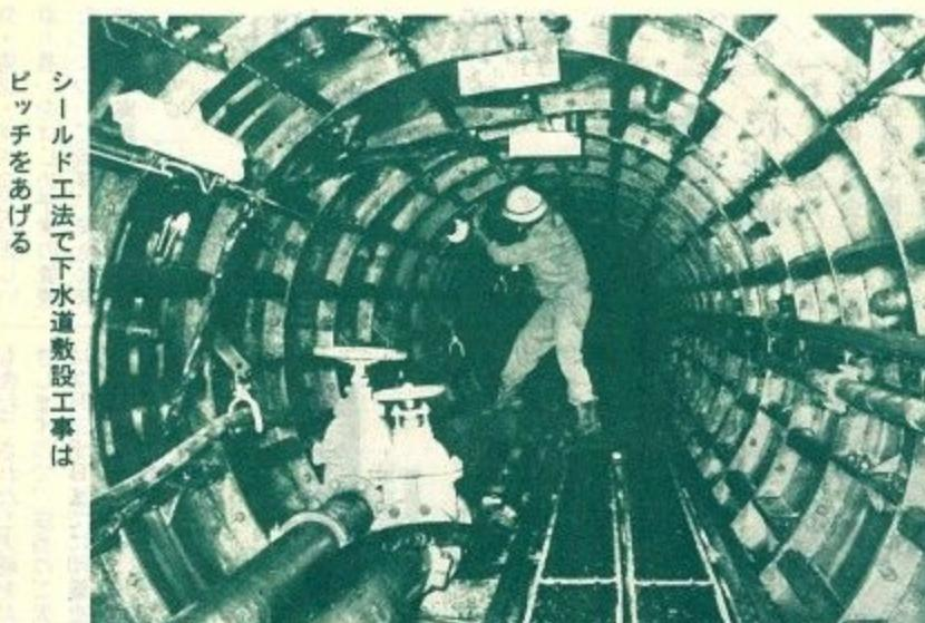
シールド工法で下水道敷設工事は、ピッチをあげる
