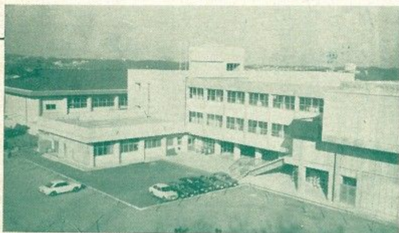
富雄第三小学校完成（4月1日開校）
