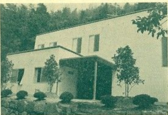
完成した興東公民館
