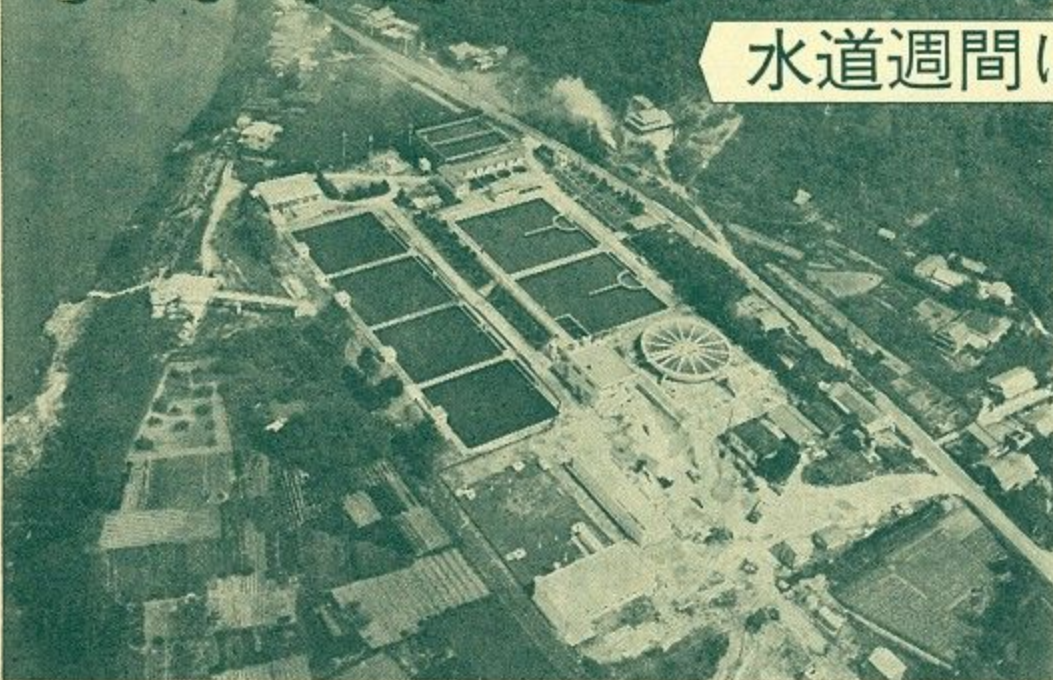
着々増強工事の進む木津浄水場（第4期拡張事業）
