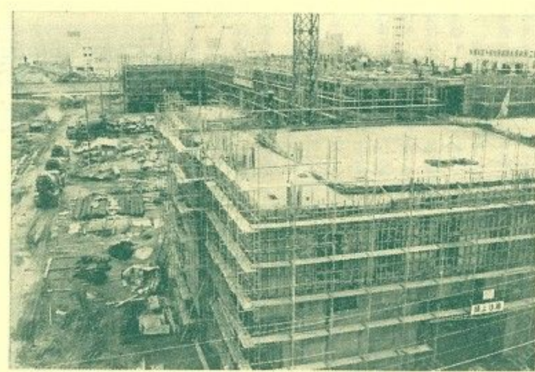
着々進む新市庁舎建設工事
