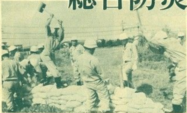
▲ 決壊した堤防を土のう積み工法で復旧する消防団員
