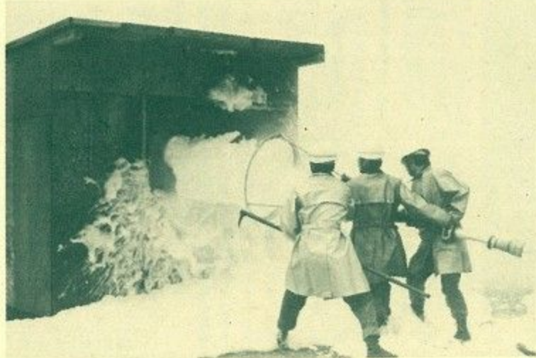
地下店舗(想定)の小屋火災を高発泡で消火
