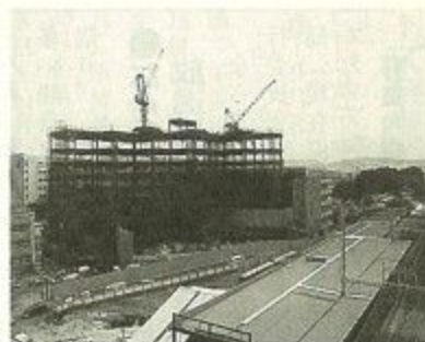
着々と工事が進む再開現場
