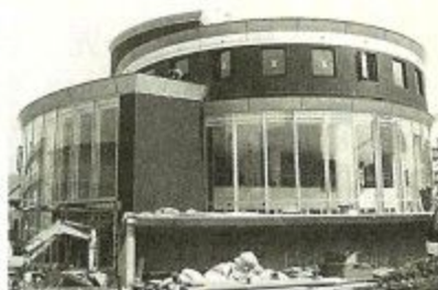
建設中の(仮称)生涯学習センター
