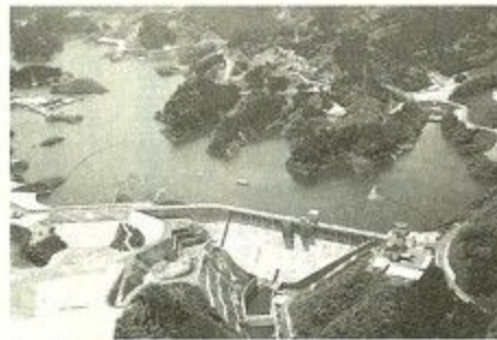
奈良市の水がめ布目ダム
