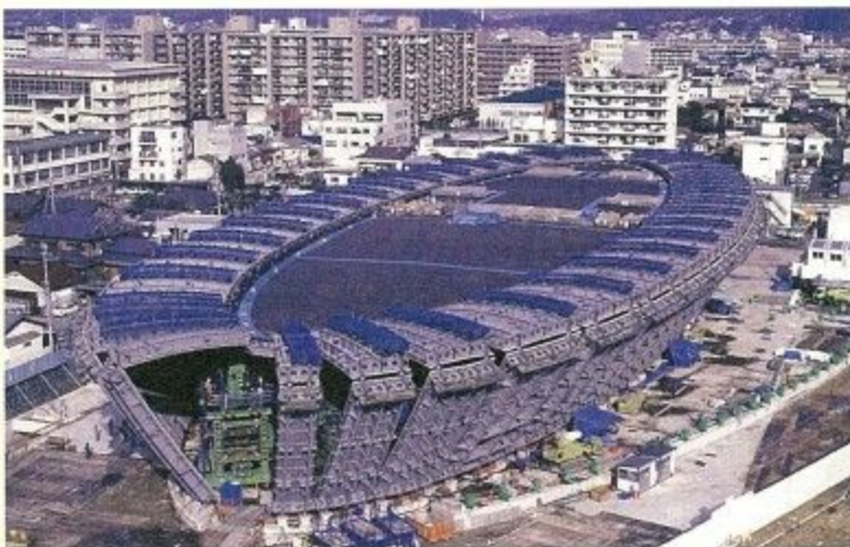
ジャッキアップされる前の市民ホール
