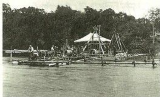
木津浄水場取水管理設工事現場 (大正七年)
