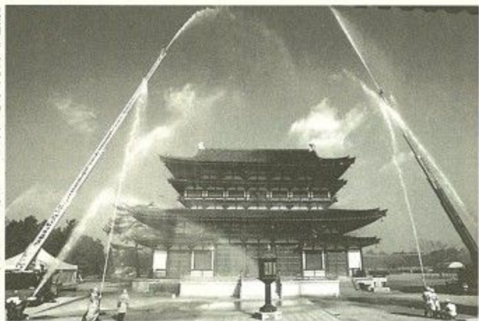
薬師寺金堂への五十メートルのはしご車による一斉放水
