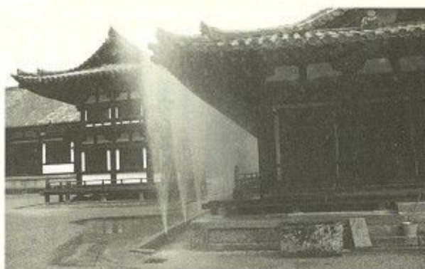
唐招提寺の鼓楼と礼堂との間に設置されたドレンチャー設備。水霧が延焼を防ぎます
