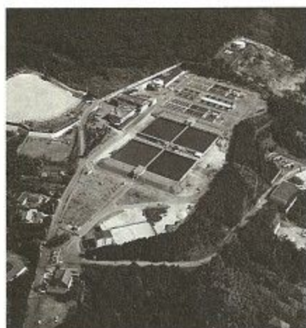
緑ヶ丘浄水場
