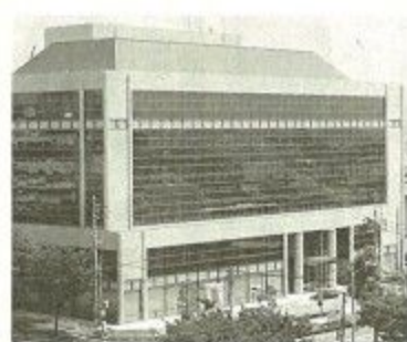
関電産業奈良センタービルディング
