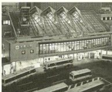
【建築文化賞部門賞(景観賞)】 近鉄学園前駅ビル(ル・シェル学園前)
