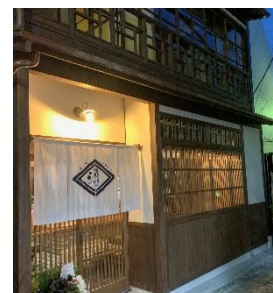
修理後に飲食店として活用されている町家
