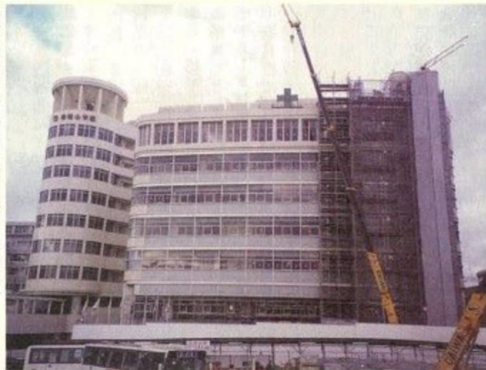
完成間近の近鉄学園前駅南地区再開発事業
