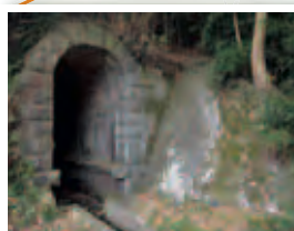
●鹿川トンネル 農業用水路の目的で造られた石組みのトンネル。現在も利用されています。
